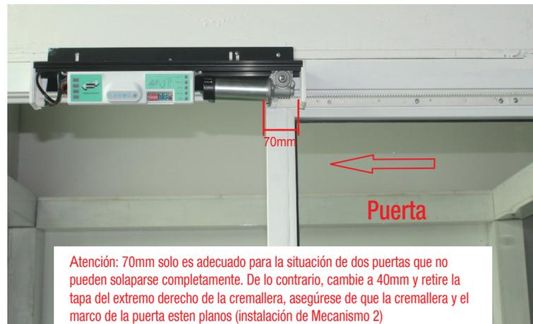
**Atención:** 70mm solo es adecuado para la situación de dos puertas que no pueden solaparse completamente. De lo contrario, cambie a 40mm y retire la tapa del extremo derecho de la cremallera, asegúrese de que la cremallera y el marco de la puerta estén planos (instalación de Mecanismo 2)
