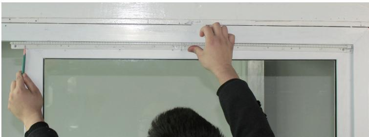
4. Reduzca 3 dientes y corte con una sierra (para usar con el tope final) desde la posición marcada previamente (si no necesita tope, corte con sierra y no será necesario reducir los 3 dientes)
