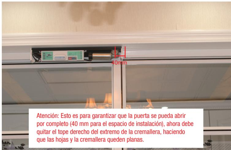
2. Ajuste la posición del sistema, consulte la marca, dejando una distancia de 25mm entre el sistema y la hoja de la puerta, luego apriete el tornillo.
